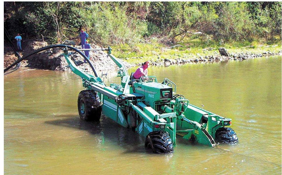
Полагане на провод под река с плугмашина
